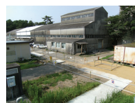
モックアップ試験室建家
