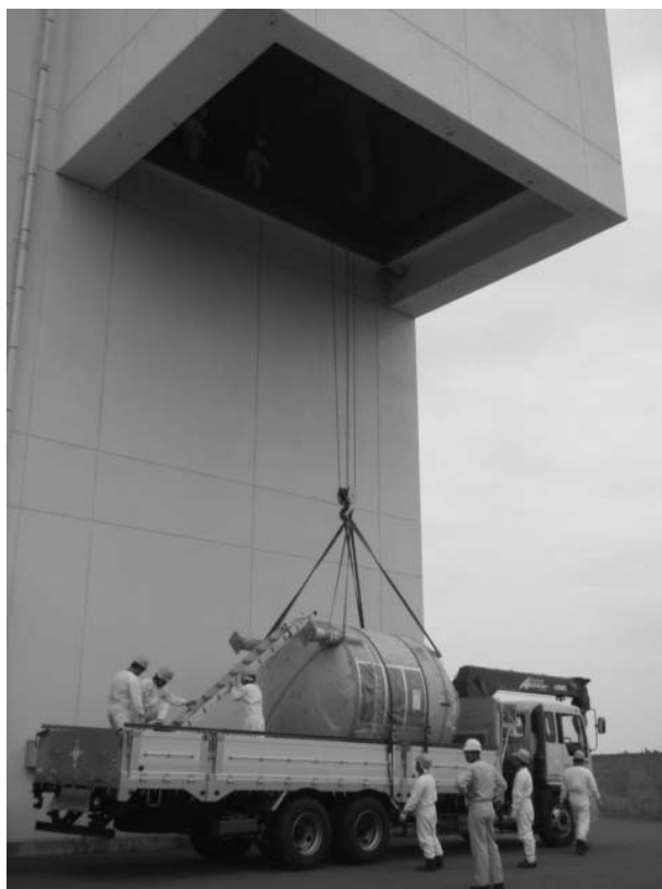
図 3.4.2-1 大型廃棄物を解体分別保管棟へ搬入
