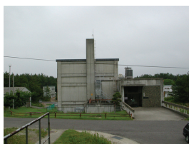
ウラン濃縮研究棟
