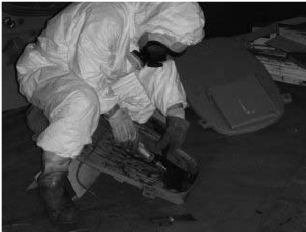
図 3.4.2-4 小型はつり機によるフィルタユニット扉のライニングはつり作業
