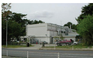
VHTRC 同位体分離研施設
