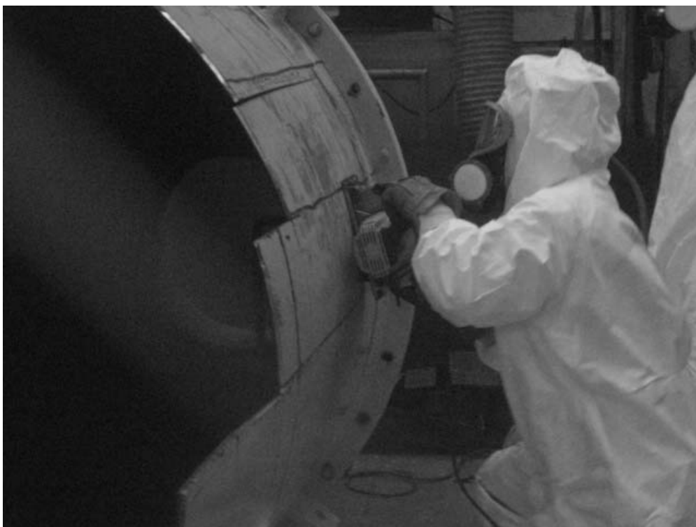
図 3.4.2-3 廃液タンクをチップソーで切断
